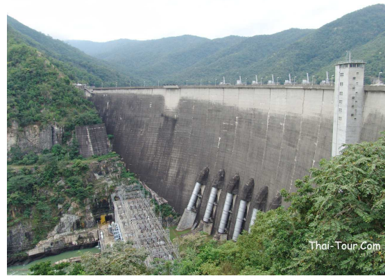
ภาพที่ 1-11 โรงไฟฟ้าพลังน้ำ ที่มา :
